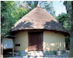
6 榨甘蔗汁小屋 由牛拉着托架在屋里转圈拉动磨盘，来榨甘蔗汁。因此，小屋也建成圆形。
